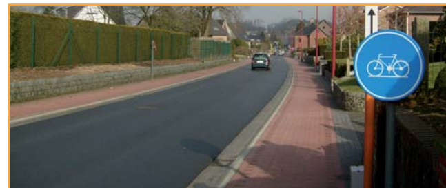
Een fietspad langs de beide zijden van de Pastoor De Vosstraat verbindt Balegem met Scheldewindeke.
